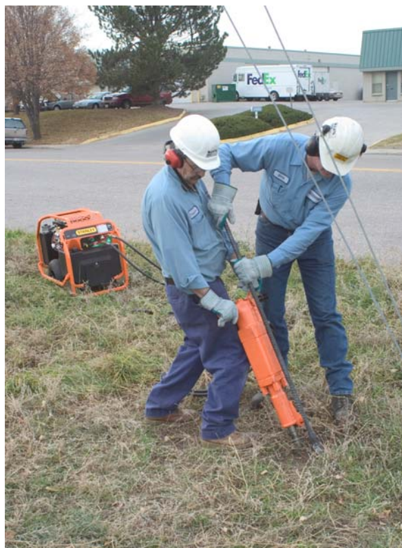
Верхушка анкерного стержня на уровне земли; установка адаптера.
